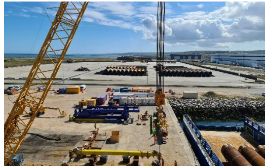
Port de Cherbourg, base logistique pour l'installation du parc
