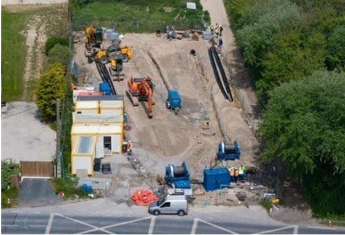
**A l'atterrage, les câbles sont tirés dans des fourreaux préalablement enterrés dans des tranchées ou passés en forage dirigé**
