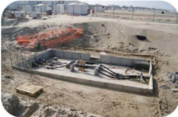
**La jonction entre les câbles sous-marins et les câbles souterrains s'effectue dans une chambre d'atterrage. Il faut une chambre par câble.**
