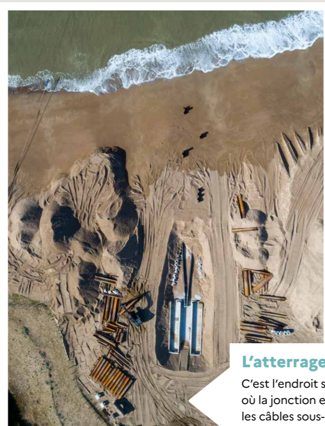
Exemple de jonction d'atterrage en phase travaux
