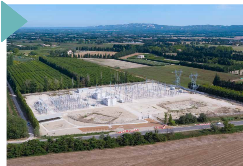
Poste de raccordement à 225 000 volts
