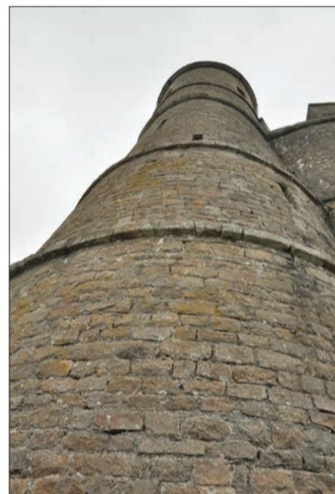
**Fig. 33 :** Les murs sont percés d'embrasures permettant de défendre la presqu'île avec des armes individuelles (mousquets). La tour est rythmée horizontalement de « cordons », bandeaux très saillants empêchant l'escalade.
