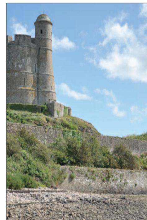
**Fig. 34 :** La tour domine un ensemble de remparts bastionnés se défendant en « profondeur ». Le parapet supérieur défendant le chemin de patrouille inférieur.
