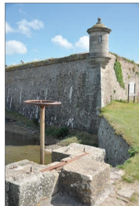
**Fig. 32 :** Des vannes permettent d'ouvrir ou fermer des écluses pour faire pénétrer l'eau à marée haute. Une guérite surplombe un angle permettant de couvrir les angles morts des courtines.
