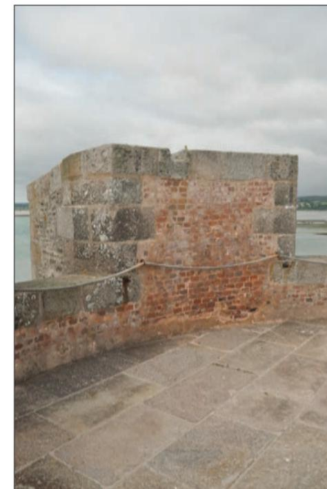
**Fig. 31 :** Au sommet de la tour se trouve une batterie : une plate-forme dont le parapet est ouvert par 6 embrasures pour laisser passer les tirs des canons.
