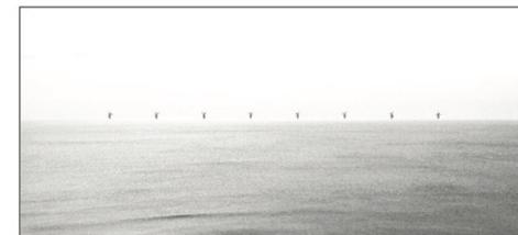
Fig. 12 : Schéma d'implantation « radial » donnant l'illusion d'un alignement équidistant depuis un point de vue précis
