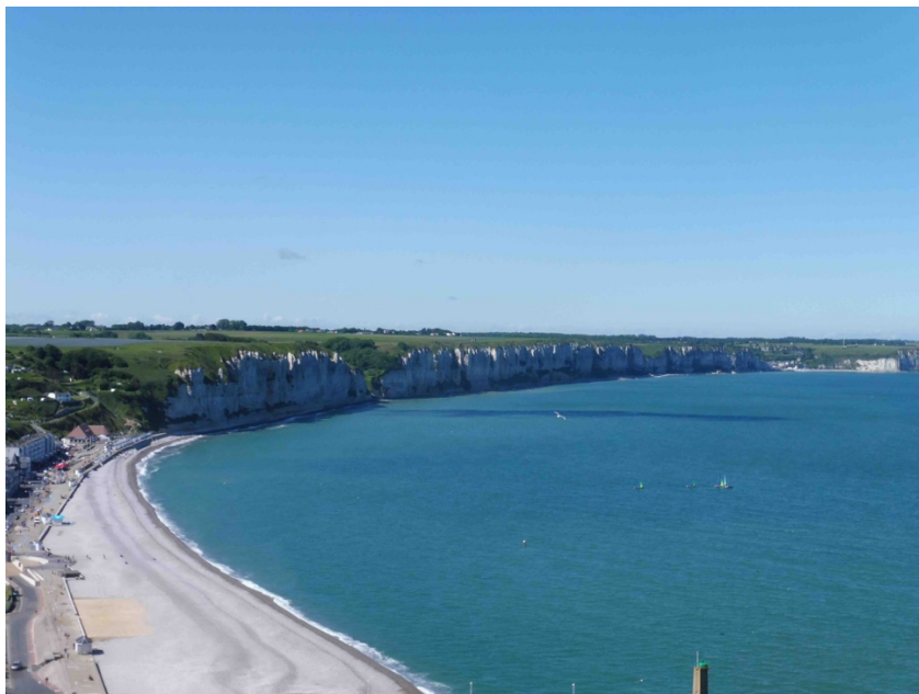
Photo n°2 : Secteur de Fécamp à Yport
