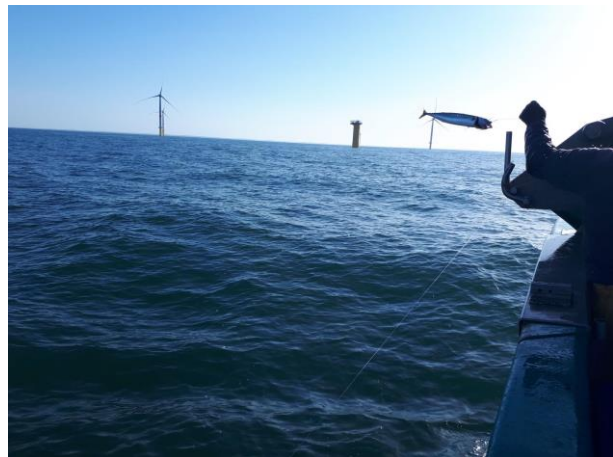
Virage d'une ligne dans le parc éolien (juin 2022)
