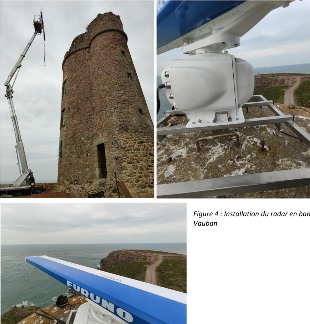
Figure 4 : Installation du radar en bande S sur la tour Vauban
