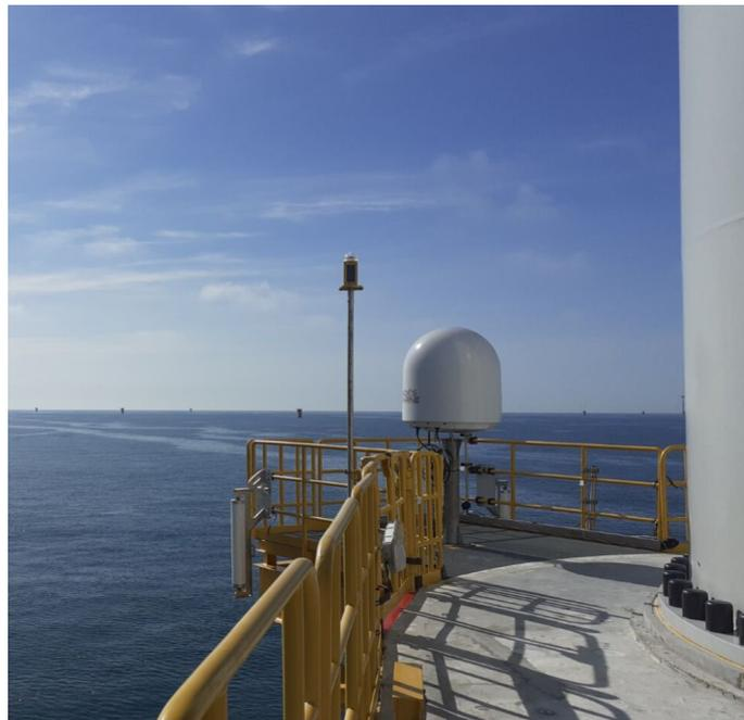
FIGURE 17 – PHOTO DU RADAR 3D DIADÈS MARINE INSTALLÉ SUR LA FONDATION A07
