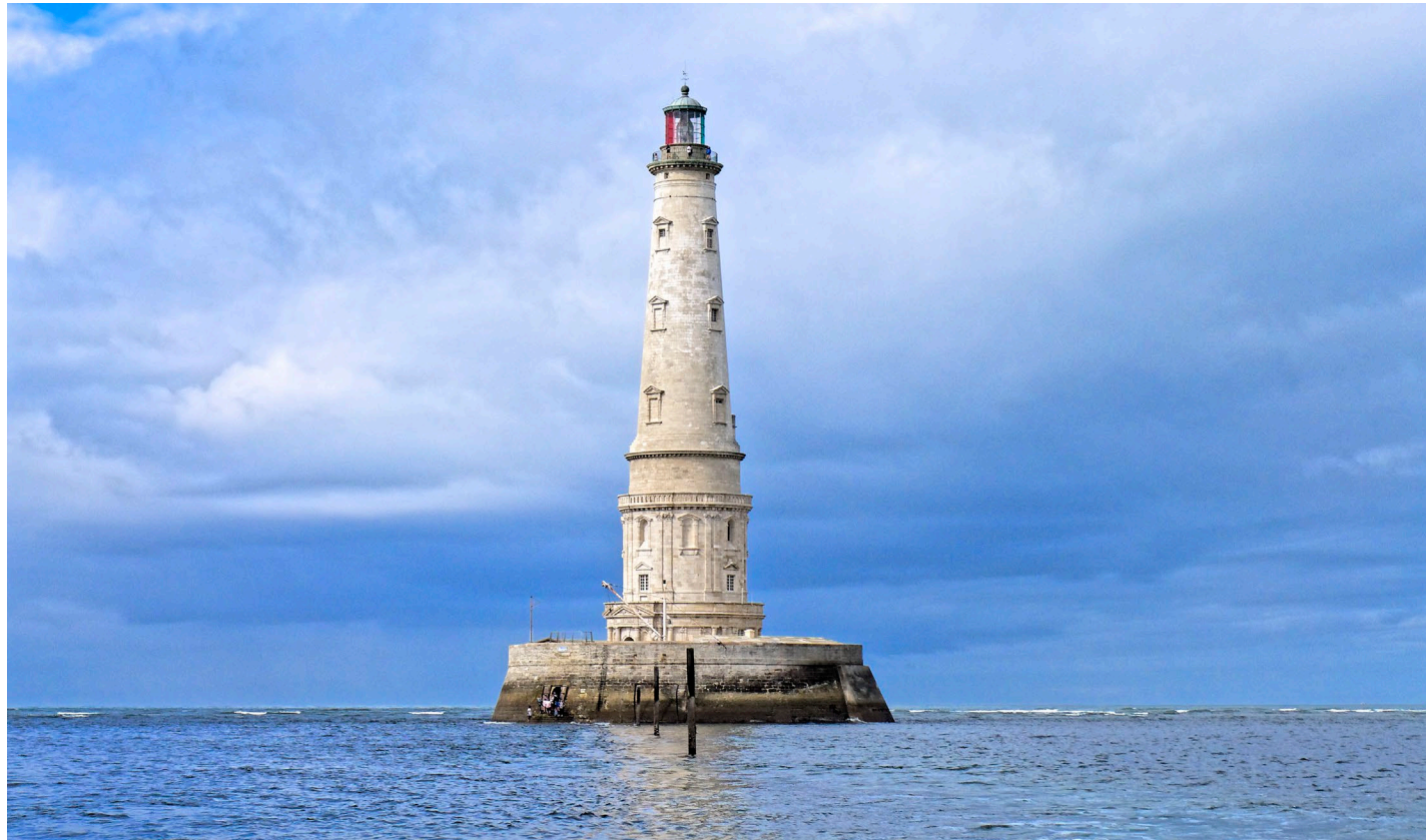
Figure 77 : le Phare de Cordouan (© DRAC Nouvelle-Aquitaine)
