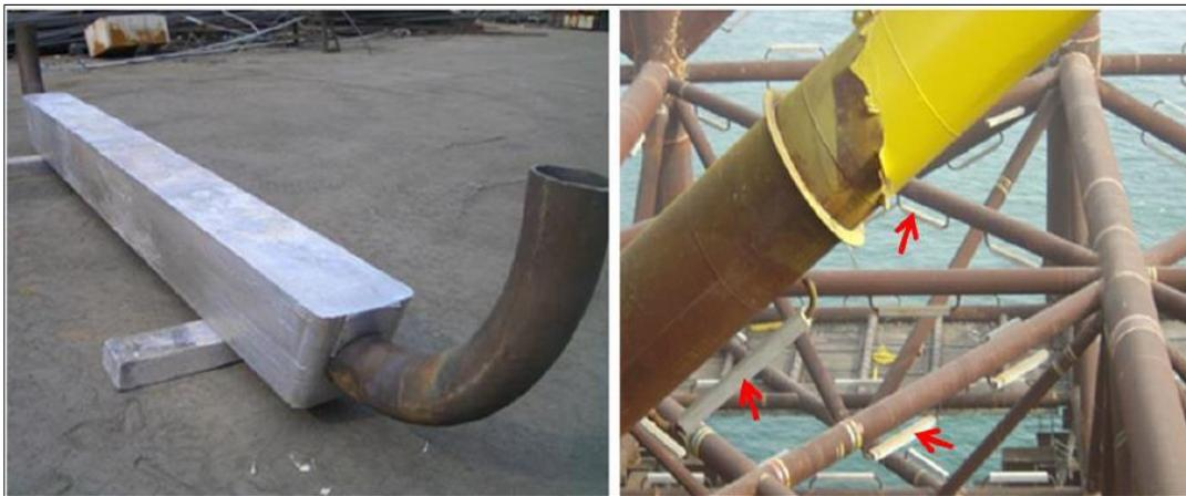
Figure 9 : anodes sacrificielles sur une fondation jacket ([www.comsol.com](http://www.comsol.com) in Yark et al.(2016))
