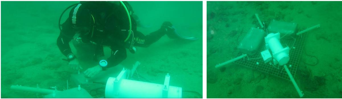
Figure 32. Pose et montage des poids sur une station STATEM par les plongeurs d'IDRA Bio et Littoral.
