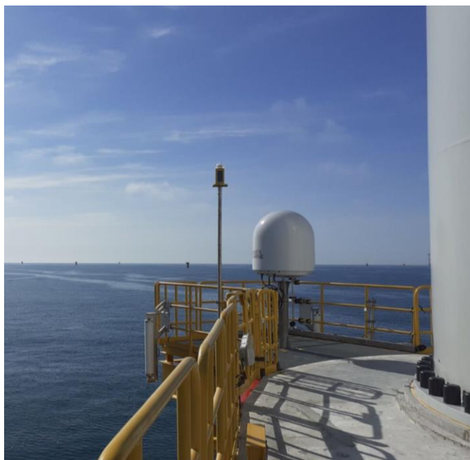
FIGURE 18– PHOTO DU RADAR 3D DIADES MARINE INSTALLE SUR LA FONDATION A07
