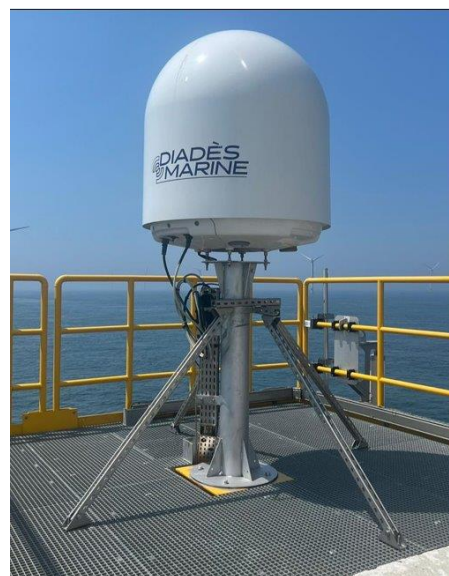
FIGURE 17. PHOTO DU RADAR AVEC L'INSTALLATION DE SANGLES CARGO POUR STABILISER LE RADAR DE FAÇON TEMPORAIRE (PHOTO DE GAUCHE) PUIS INSTALLATION DES JAMBES DE RENFORT COMME SOLUTION PERMANENTE (PHOTO DE DROITE)
