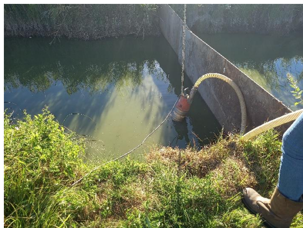
Pompage pour mise en assec
