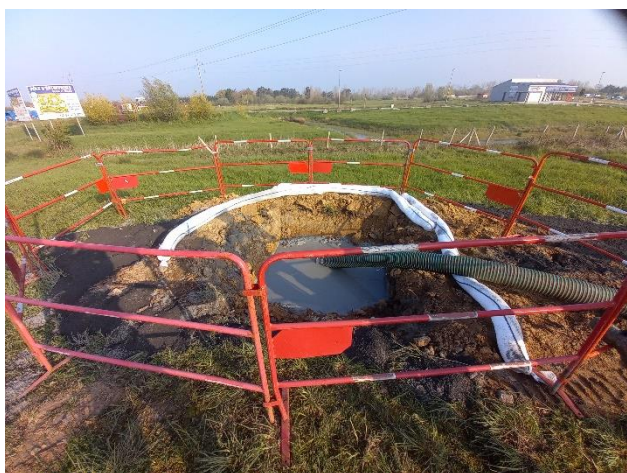
Hydrocurage d'une remontée de bentonite
