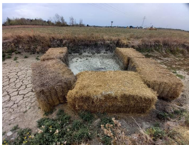
Confinement d'une remontée de bentonite (avant hydrocurage)
