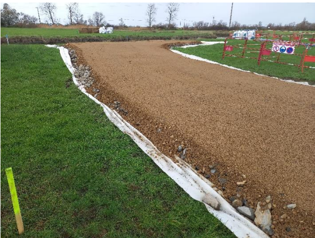
Piste sur matériaux d'apport + géotextile
