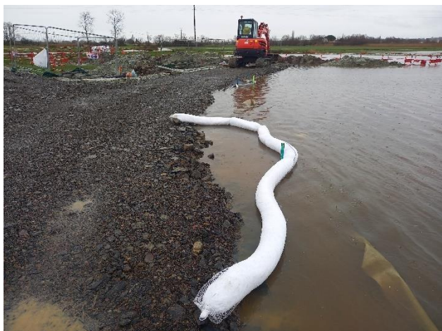
Utilisation systématique de boudin absorbant en cas de risques de pollution milieu aquatique
