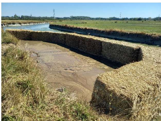
Remontée importante de bentonite dans un étier en eau au PSO11 (fuite contenue par une ceinture de bottes de paille)
