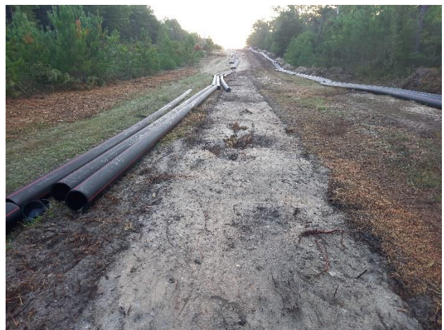
Décapage et mise en stock avant passage de la trancheuse dans la forêt dunaire
