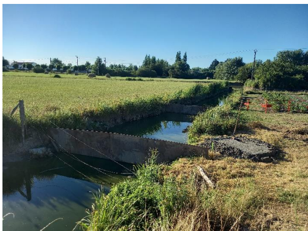
Mise en place de batardeaux
