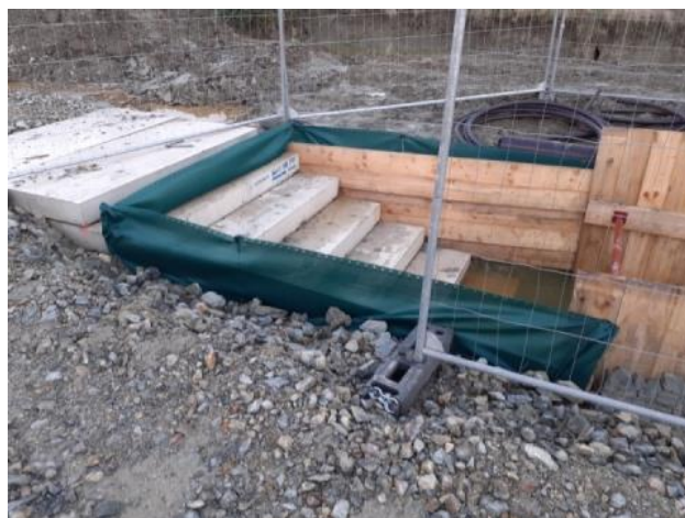
Filet anti-amphibiens sur une extrémité de chambre de jonction
