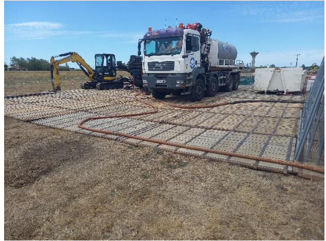
Plateforme de forage sur plaque de roulage
