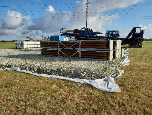
Plateforme de forage sur matériaux d'apport + géotextile
