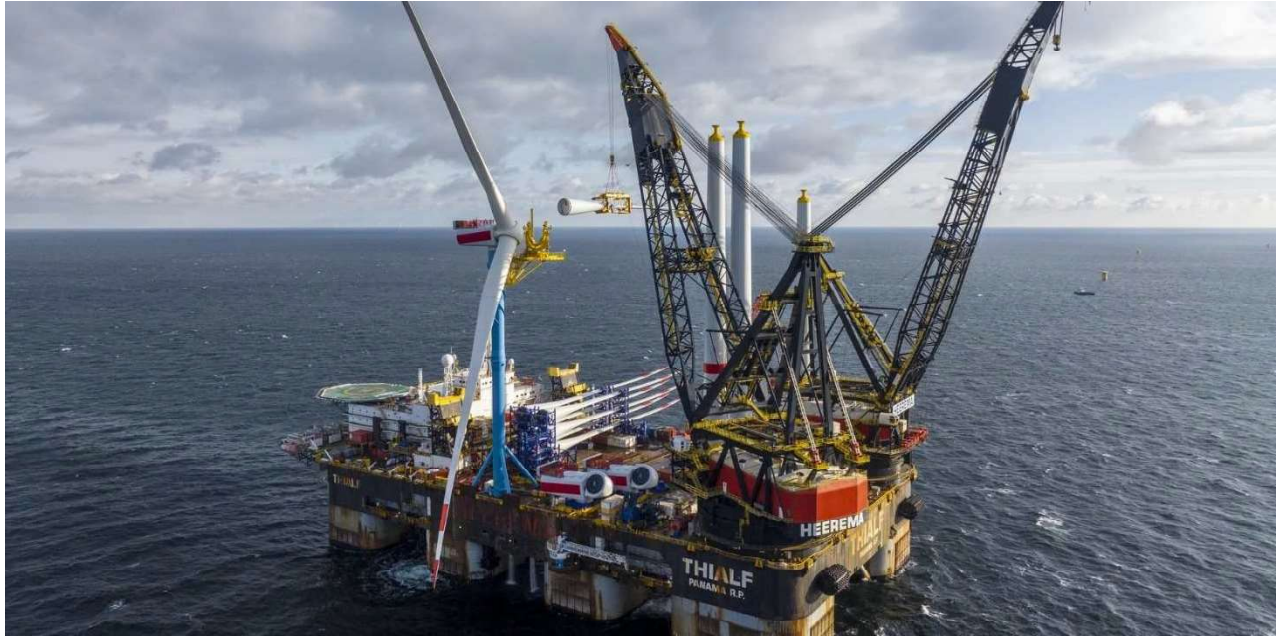
Figure 5-13 Thialf de Heerema installant des turbines sur le projet Arcadis Ost 1
