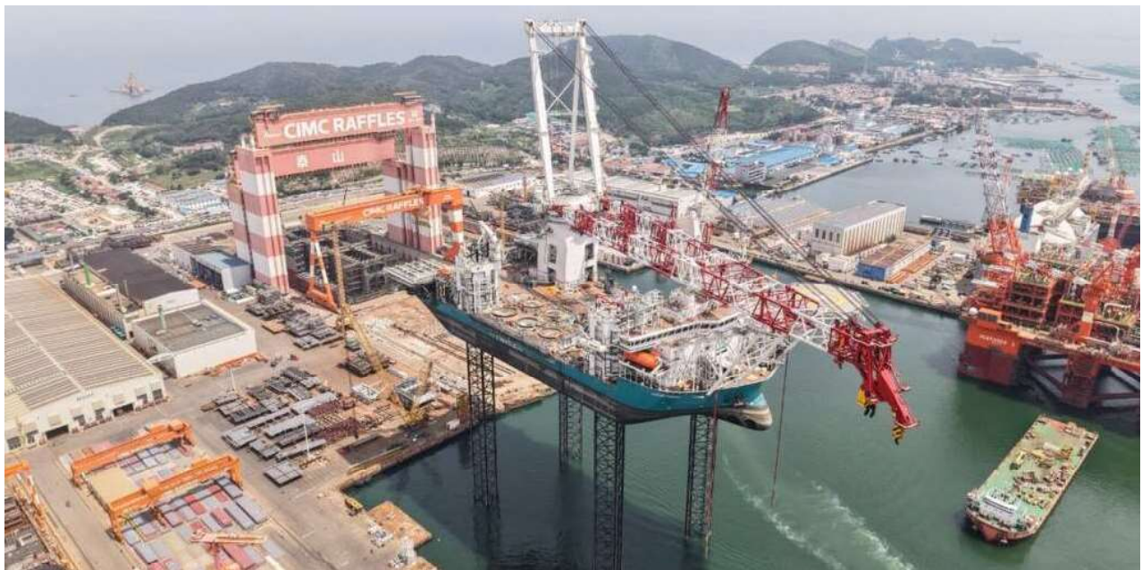
Figure 5-16 DEME Norse Wind, test de levage des jambes (longueur 124 m), aout 2025
