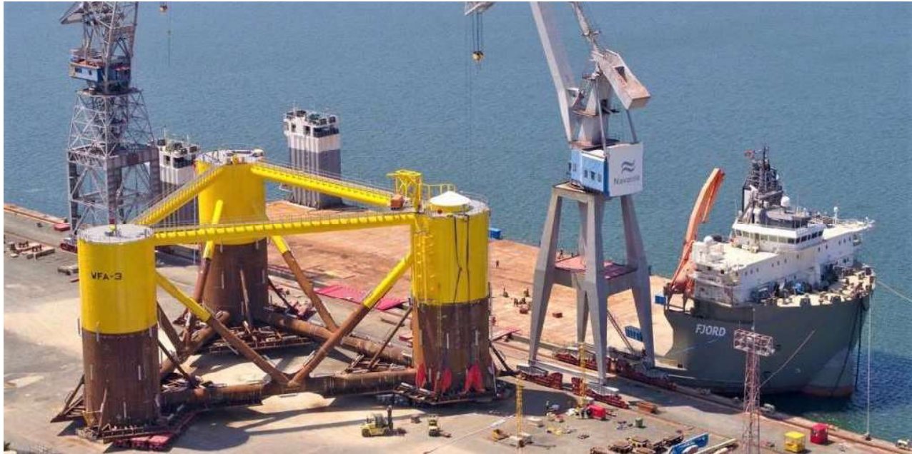
Figure 5-14 WindFloat Atlantic structure dans le chantier de Navantia-Fene, Espagne
