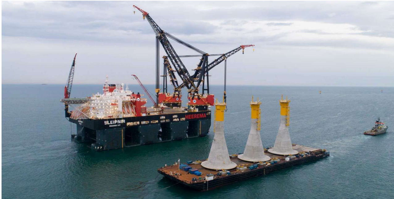
Figure 5-1 Installation de la fondation GBS de Fécamp avec Sleipnir SSCV
