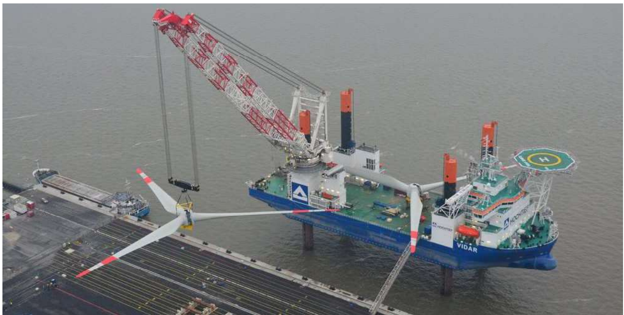
Figure 5-11 Chargement du rotor terminé
