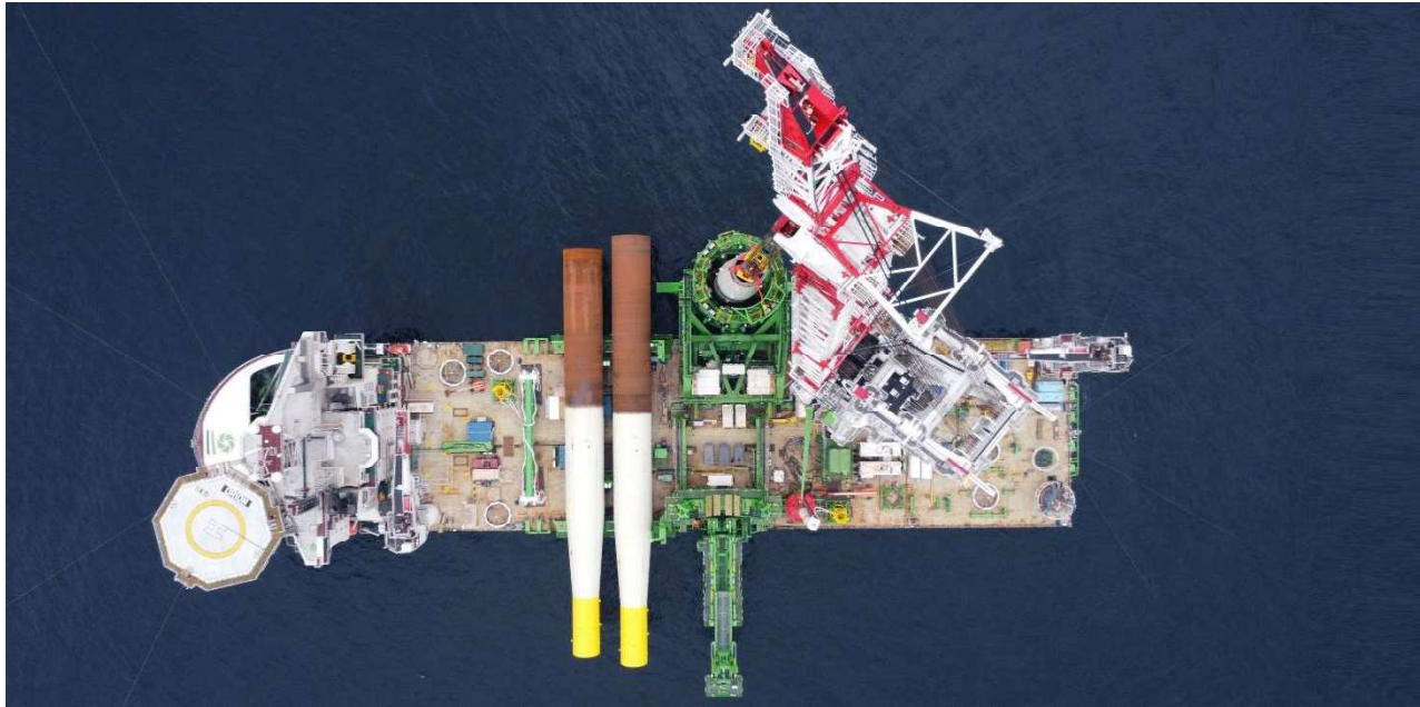
Figure 5-2 Soulèvement de monopieux à Arcadis Ost 1 (110 m de long, 9,5 m de diamètre, 2 100 t de poids) Source : Parkwind / DEME Offshore, https://parkwind.eu/news/first-arcadis-ost-1-monopile-installed , consulté le 29 septembre 2025
