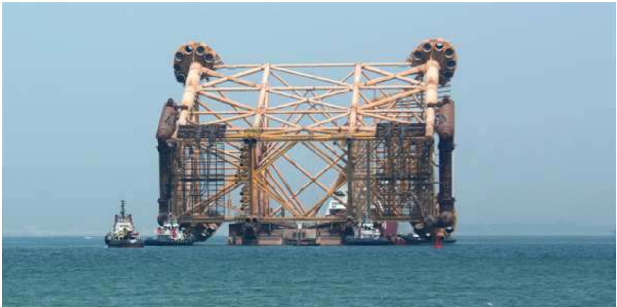
Figure 4-4 Transport de jacket pour la plate-forme pétrolière Mariner A
