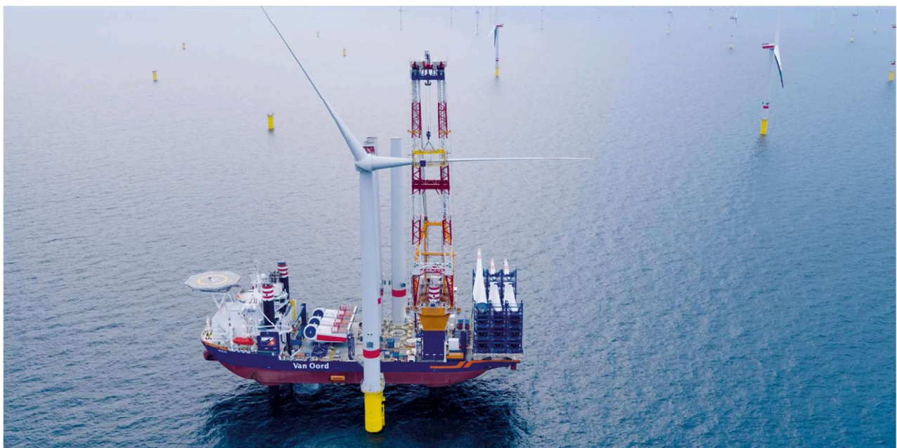
Figure 5-9 Installation d'une turbine à Deutsche Bucht
