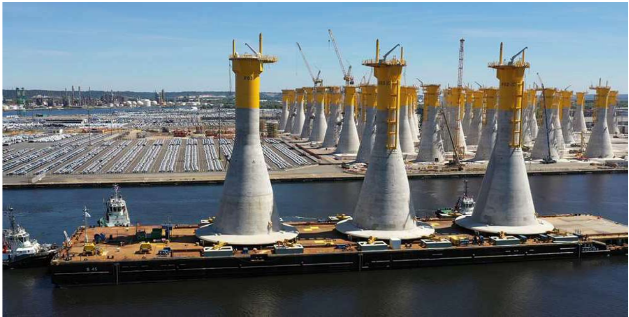
Figure 4-2 Site de fabrication de GBS à Fécamp au Havre
