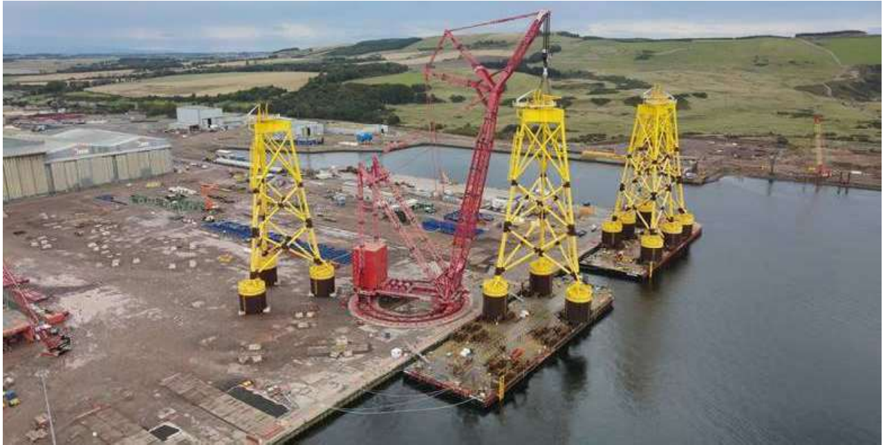
Figure 5-5 Chargement des jackets de godets d'aspiration du projet Seagreen sur des barges de transport
