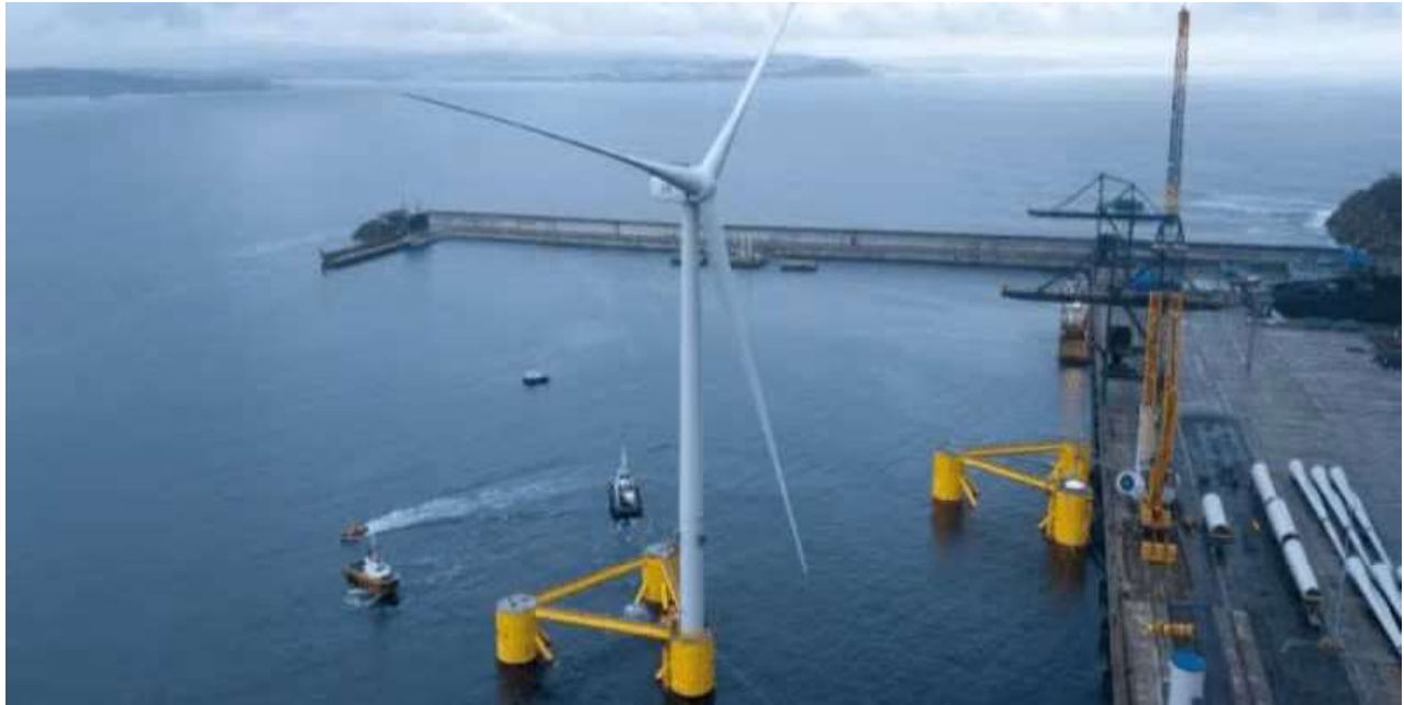
Figure 5-15 Intégration de l'éolienne à quai, projet EFG
