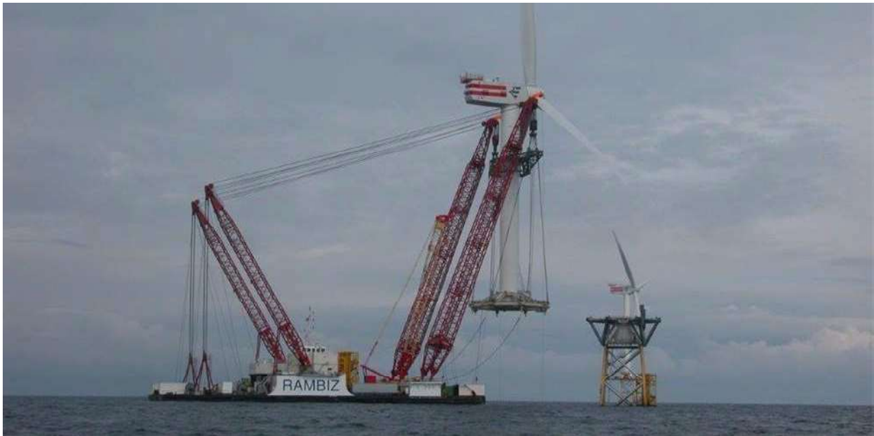
Figure 5-12 Installation de turbines du projet Beatrice Demo
