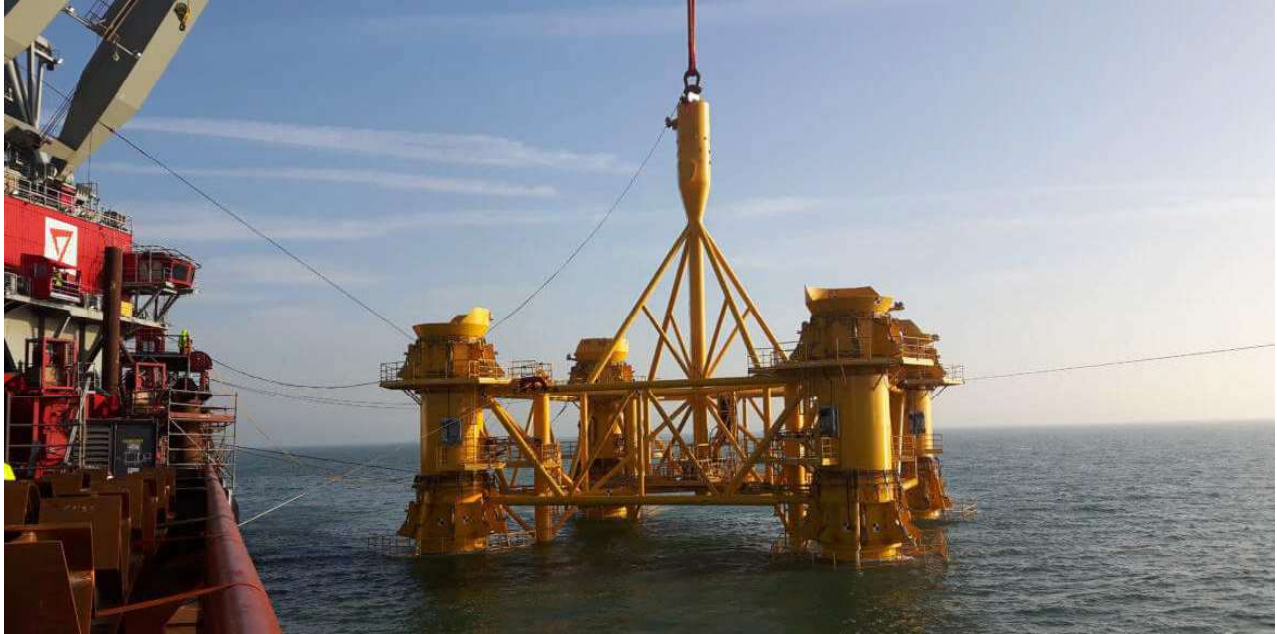
Figure 5-3 Abaissement du gabarit de pré-empilage
