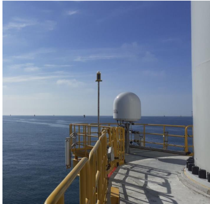
FIGURE 10- RADAR 3D DIADES MARINE INSTALLE SUR LA FONDATION A07
