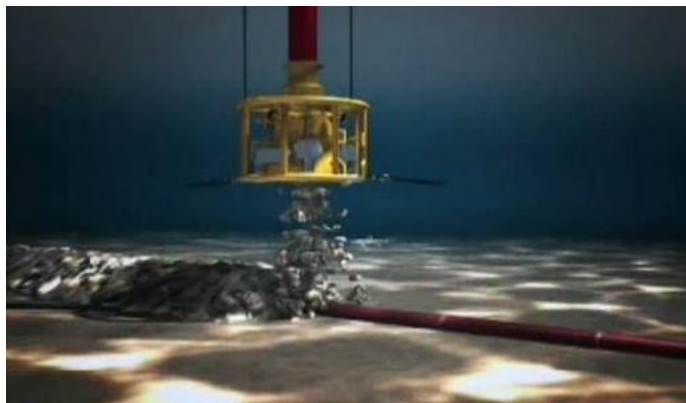
Figure 66. Enrochement par tuyau d'amené (à gauche : fall pipe ) ou par navire de transbordement (à droite : side dumping ) (Source : RTE, 2016)
