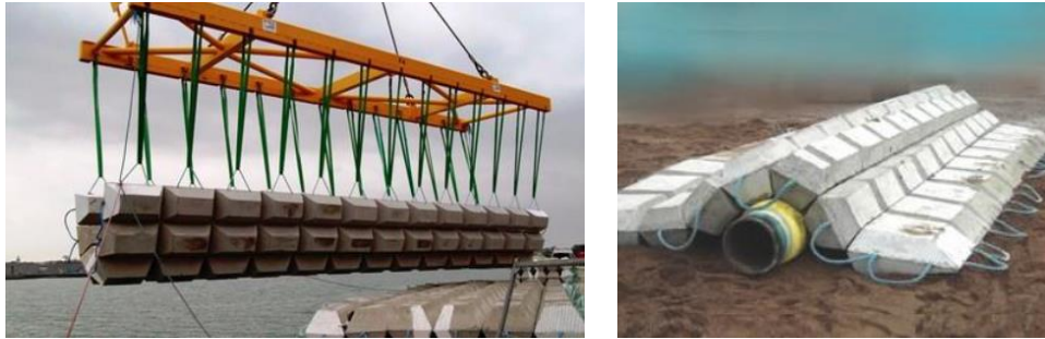
Figure 67. Aperçu des matelas en béton
