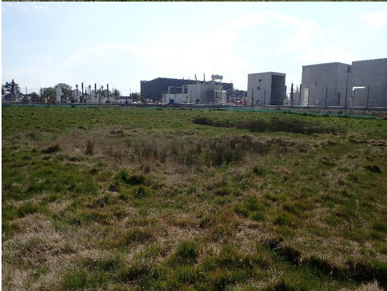
12 Vue sur la mare n°1 et poste électrique. Trépied au même endroit que PV 11.
