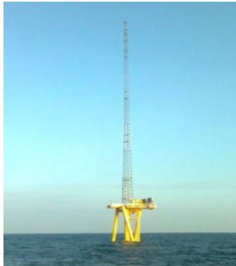
Le **mât de mesure** d'une hauteur de 100 m environ, installé face aux vents dominants, permet de recueillir des données météorologiques
