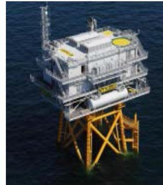
Le **poste électrique** comprend les équipements de transformation permettant d'élever le niveau de tension électrique, et de comptage de l'énergie délivrée par les éoliennes.
