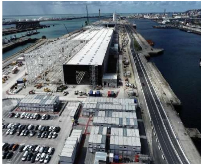
Le Havre - Usine Siemens Gamesa (éoliennes)
