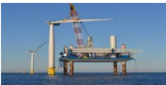
Installation des éoliennes
