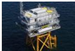
Poste électrique en mer
