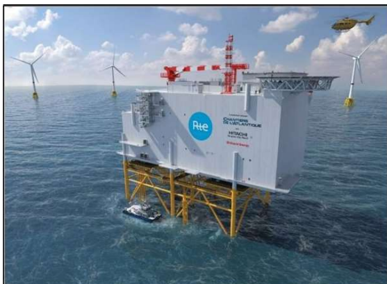
Poste en mer 320kV L100m* l60m* H45m
