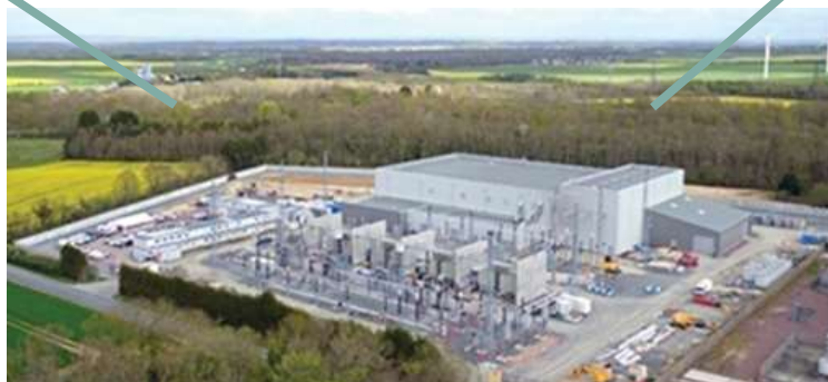
Station 320kv située près de CAEN (IFA2)
