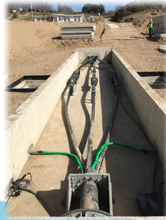
Chambre de jonction d'atterrage enterrée une par liaison \approx 17 \text{ m (L)} \times 3 \text{ m (l)} \times 1 \text{ m (H)}
