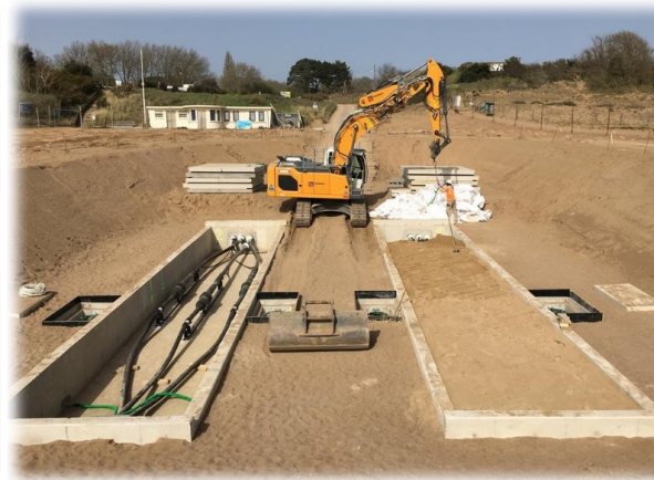
Chambre de jonction d'atterrage enterrée une par liaison \approx 17 \text{ m (L)} \times 3 \text{ m (l)} \times 1 \text{ m (H)}
