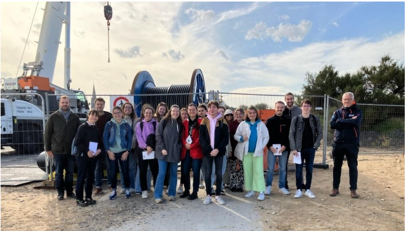
Visite des élèves de Science-Po sur le chantier de l'atterrage du parc éolien en mer du Calvados (Bernières-sur-Mer)
