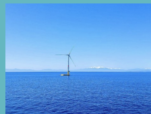
Eolienne de la ferme EolMed au large de Gruissan - Source : EolMed
