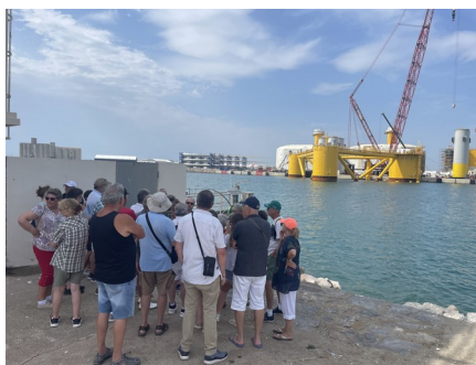
Observation du chantier d'assemblage de la ferme pilote EFL le 25 juin 2025
