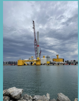
Chantier d'assemblage EFGL
